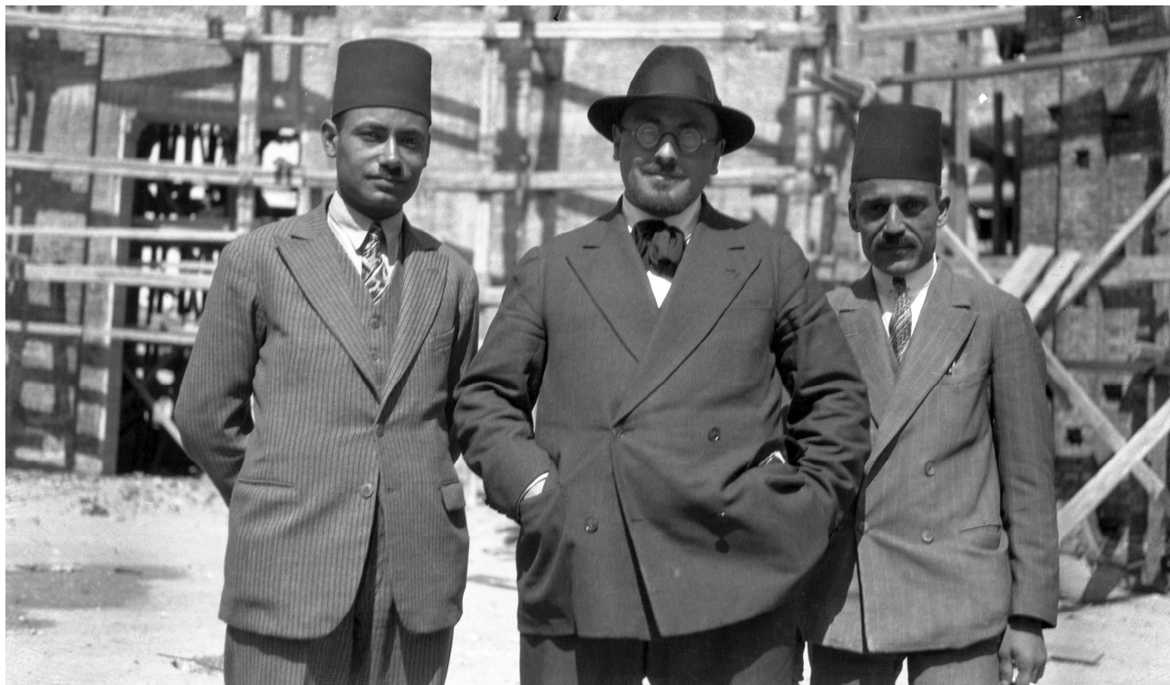
La moschea al-Mursi Abou al-'Abbas, Eugenio Valziana, Mario Rossi, Alessandria d'Egitto, Midan al-'Abbas, 1928-1944: foto di cantiere. [Archivio familiare Rossi, Milano]
