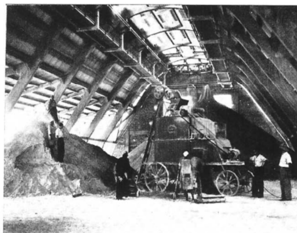
USINE DE KAFR-EL-ZAYAT — ENSACHAGE DU SUPERPHOSPHATE
